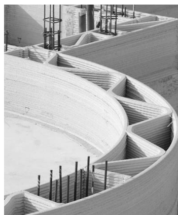
b) Edificação reforçada
